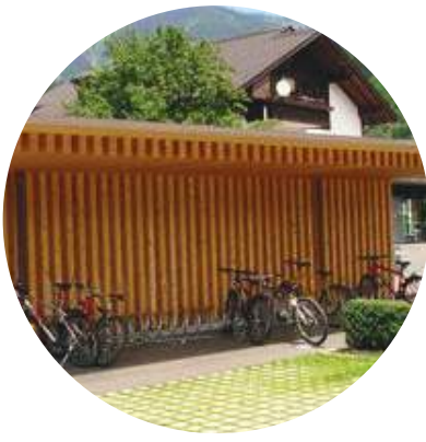
Abris vélo extérieurs protégés
