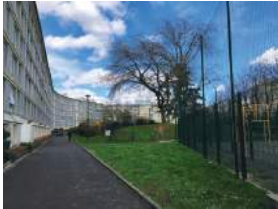
Grand ensemble des Bas-Coquarts - Résidence Lafayette
