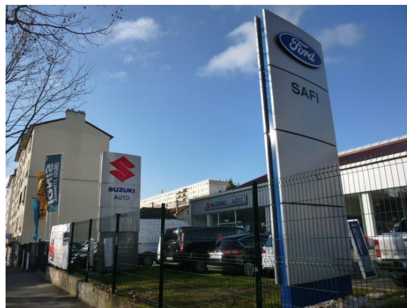
Figure 40 : enseigne scellée au sol.
