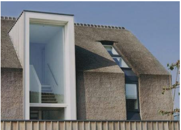
Réalisation d'ouvertures très contemporaines dans une toiture de chaume classique.
