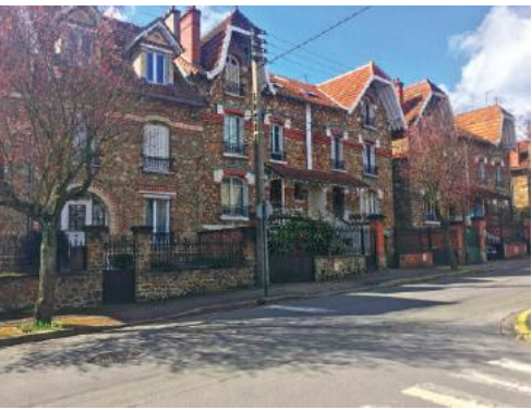
Lotissement du Petit Chambord Av. du Château
