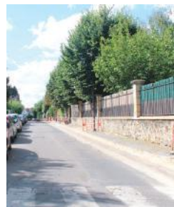
Couronne de l'arbre au-dessus de la clôture
