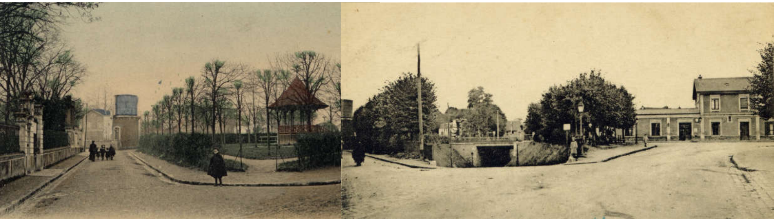
↑ Avant / après le percement du tunnel des Blagis
