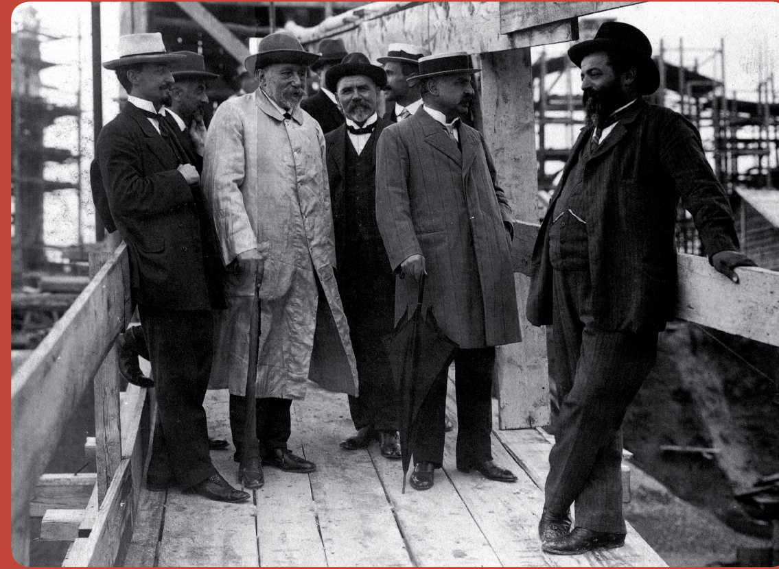
François Hennebique en visite sur le chantier du pont du Risorgimento à Rome, le 7 octobre 1910. (Fonds Bétons armés Hennebique. CNAM/CIAF/Cité de l'architecture et du patrimoine/Archives d'architecture du XX e siècle).
