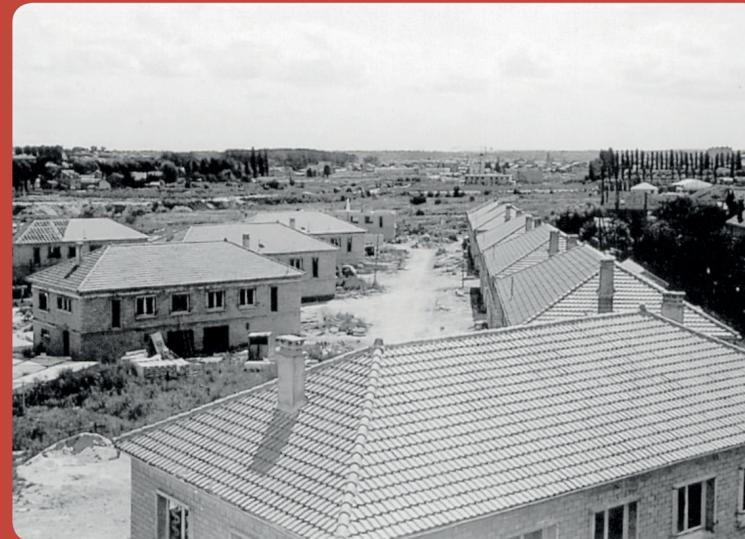
Disposés en biais afin d'éviter les vis-à-vis, les pavillons jumelés sont choisis en raison d'économie de construction.
