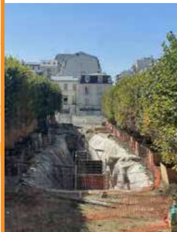
Travaux de génie civil pour l'accueil du bassin de rétention d'eau
